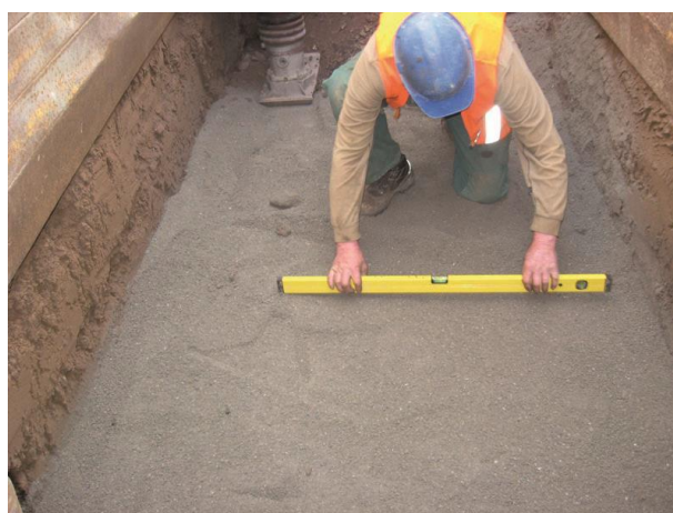
Slika 1 i 2: Priprema podloge za polaganje šahtova
