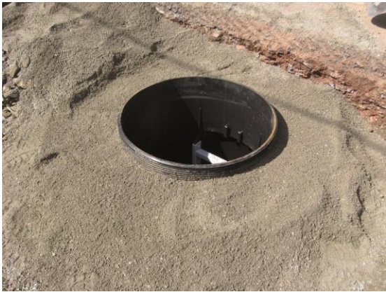
Slika 9 i 10: Postavljanje betonskog prstena za prihvat opterećenja
